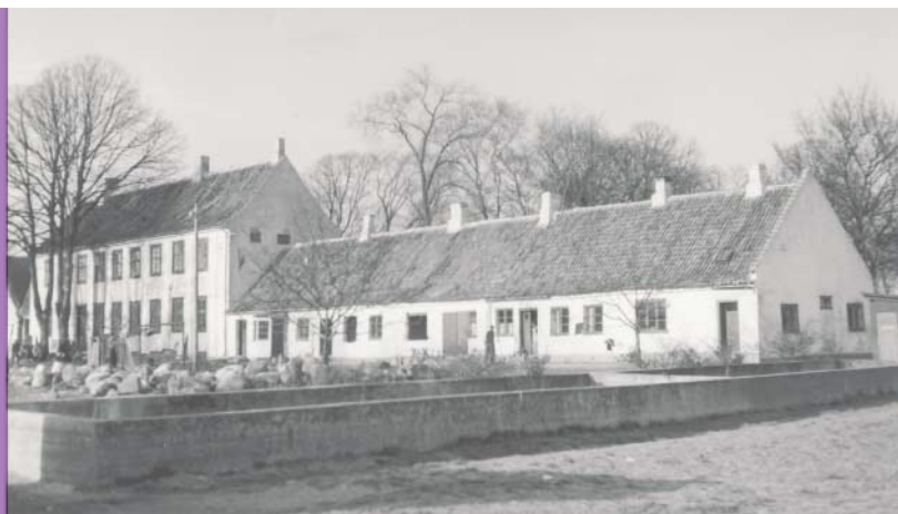
Kastrupgård med vandbassin forrest samt hovedbygning og sidelænge mod syd, hvor Ole og hans familie boede. Foto: Viggo Iversen, ca. 1957
